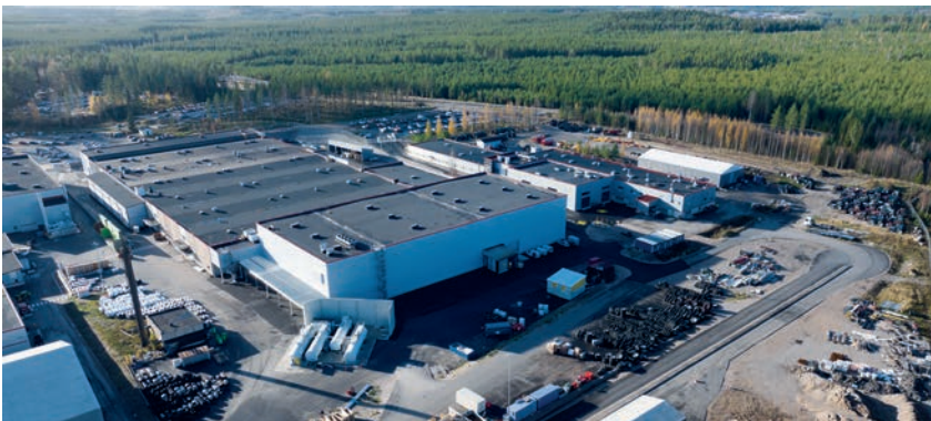
Voimansiirtotehdas sijoittuu tuotekehityskeskukseen ja kokoonpanotehtaan väliin. Myös ulkoalueita on järjestelty ja uuden pohjoisportin ansiosta rekka liikenne voimansiirtotehtaan ympärillä on vähentynyt alle puoleen.
